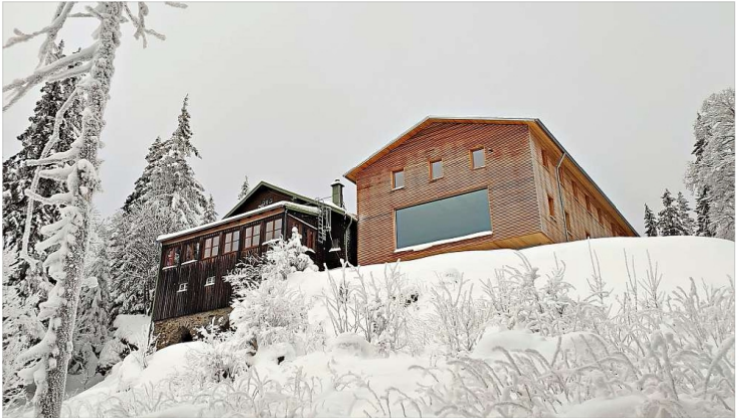
Nahtlos soll im Sommer der Betrieb vom alten ins neue Schutzhaus verlagert werden. Erst wenn der Falkenstein-Wirt mit seinem Team ins neue Haus umgezogen ist, wird das alte Haus abgebrochen; bis dahin läuft der Betrieb weiter. – Fotos: Winter/Weber
