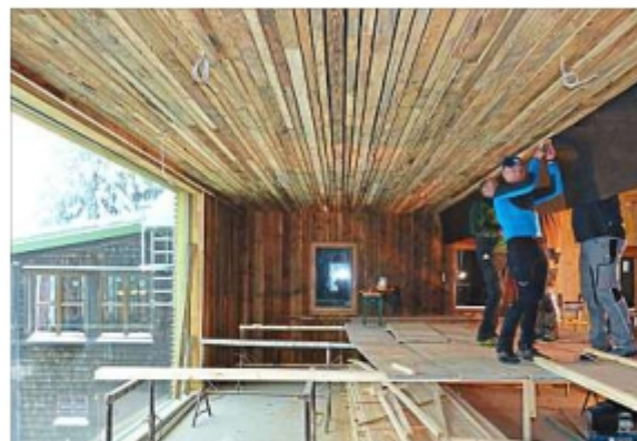
Fleißig am Werkeln sind beim Innenausbau die Mitglieder des Fördervereins. Die Innenwände in der Gaststube werden mit Altholz verkleidet.
