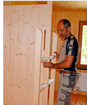
Maßarbeit in Holz: Josef Mühl von der Schreinerei Leher baut die Stockbetten ein.
