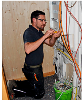
Jede Menge Arbeit gibt es noch für die Elektriker, im Bild Andreas Weber von der Firma Süß.
