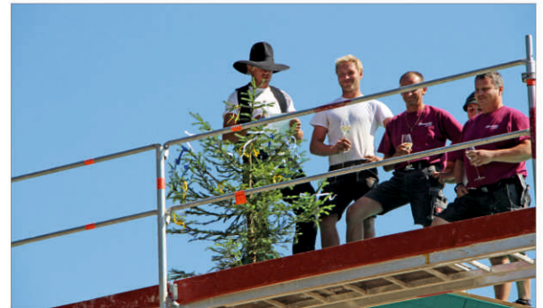
Tradition auf dem Berggipfel: Nicht fehlen darf auf der höchsten Baustelle Niederbayerns beim Richtfest der Richtspruch der Zimmerer – hier vom Dach des neuen Schutzhauses auf dem 1315 Meter hohen Falkenstein.
