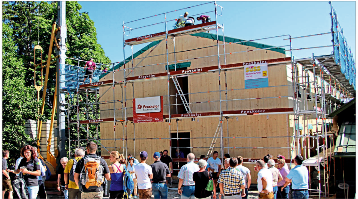
Großes Interesse am Richtfest: Gut 60 Gäste feierten mit dem Wald-Verein, dem Förderkreis und dem Bauunternehmen den großen Moment auf dem Falkenstein-Gipfel. – Fotos: Ebner
