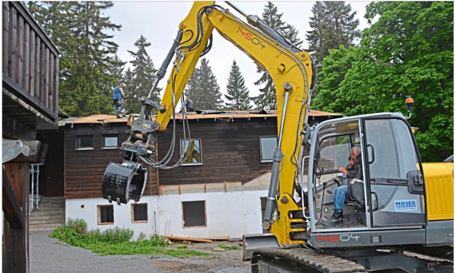
Der Abrissbagger mit Wolfgang Winter am Steuer hat am Freitag mit den Abbrucharbeiten begonnen.
