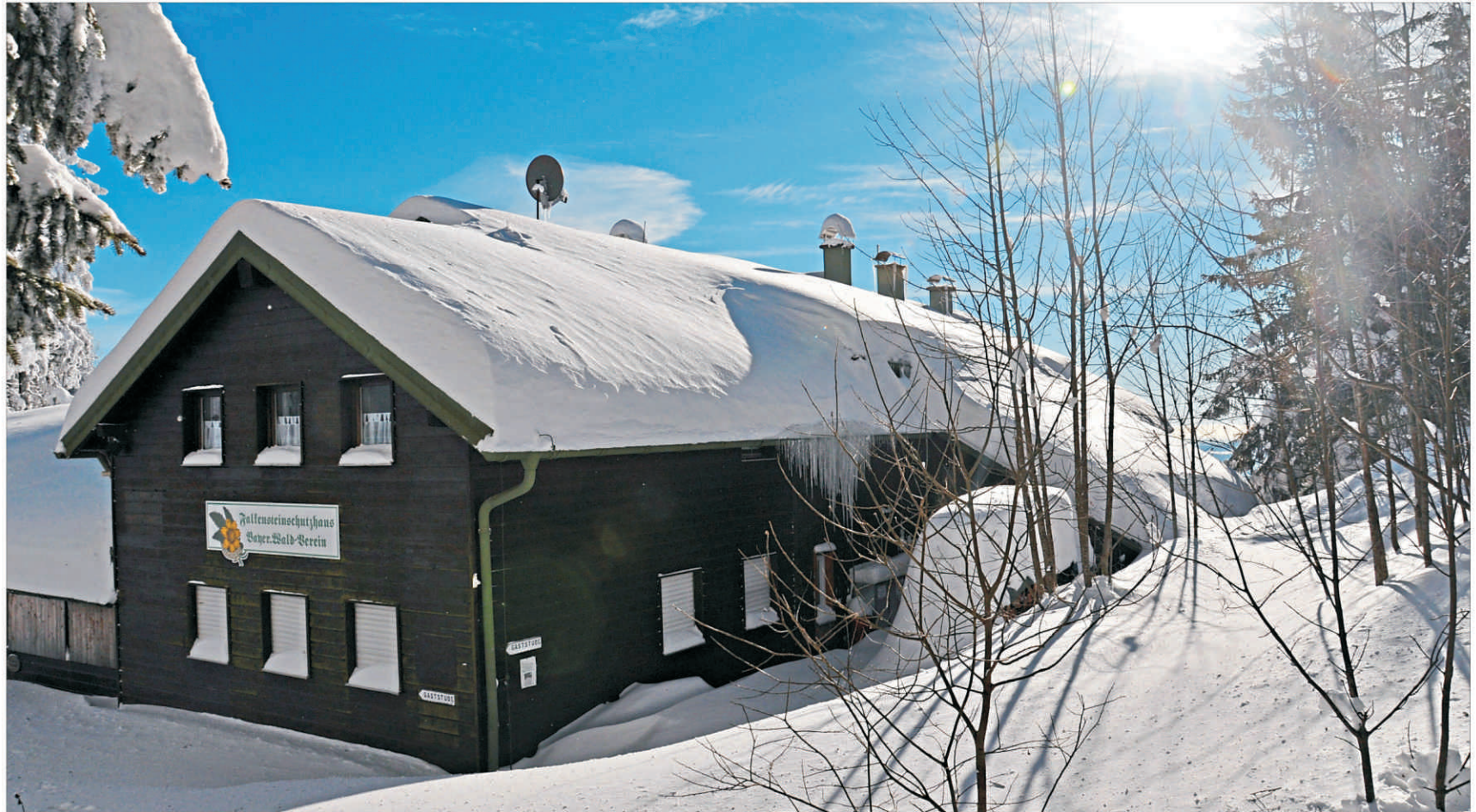
Tief verschneit präsentiert sich in diesen Tagen des Schutzhaus am Falkenstein. Höchstwahrscheinlich erlebt das 85 Jahre alte Gebäude gerade seinen letzten Winter – noch heuer soll es abgerissen und durch einen Neubau ersetzt werden. – F.: Roland Schreder
